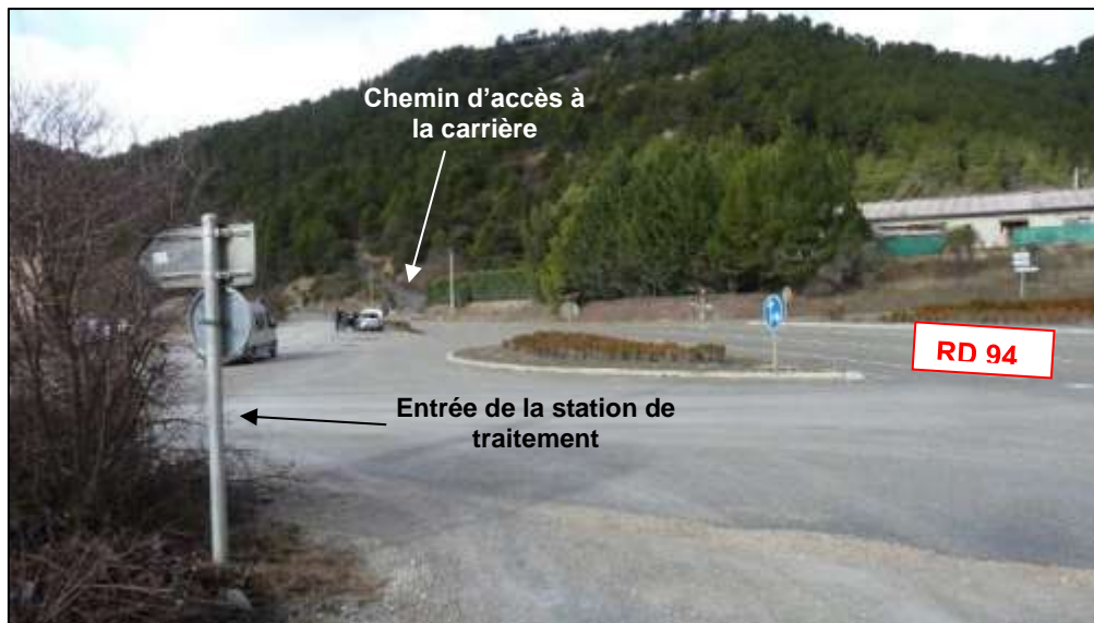
Figure 19 : Carrefour entre la D94 et la station de traitement, chemin d'accès à la carrière en arrière-plan Source : ATDx
