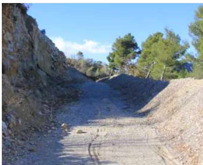
Figure 21 : piste privée d'accès au site
